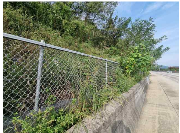
하부 야생동물유도울타리 전경
